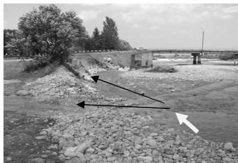
Рис.5. Розмив лівого берега і полотна дороги перед мостом через р.Лімницю у смт Перегінське
