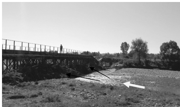
Рис. 4. Частково зруйнований міст через р.Чечву біля с.Довга Калуська. (Видно велику кількість «деревного наносу» і гребінь гряди, що зупинилася і частково розмита перед мостом)
