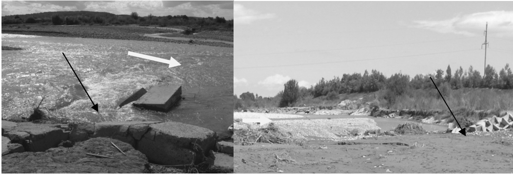
Рис.2. Розмив дамб обвалування на правому березі р.Бистриця Надвірнянська
