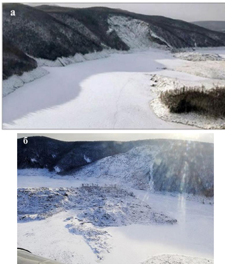
Рис. 11. Крупный оползень (11.12.20018 г.) на крутом левом склоне долины р. Бурея в 20 км выше впадения в нее большого левого притока (р. Тырма), полностью перекрывший высокой плотиной из обломков скальных пород заполненную водохранилищем Бурейской ГЭС долину реки:
